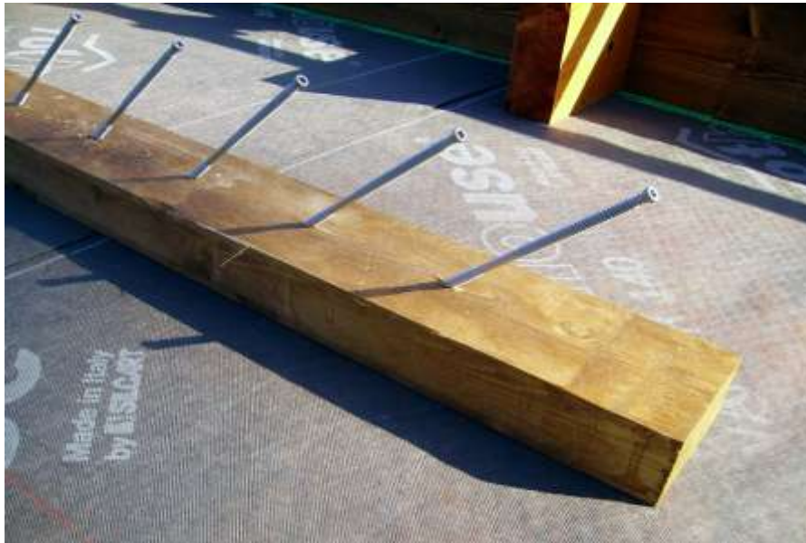
Rinforzo legno-legno travi di copertura
